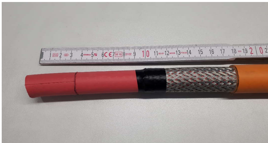
Bild 2: Fixierung des Schirmgeflechts auf der unteren Isolierlage mit Isolierband Fig. 2: Fixation of the shield braid with adhesive tape at the underlying insulation
